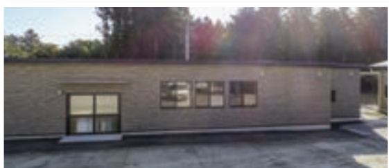
ワークセンターさくら増築工事竣工
