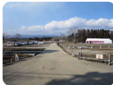
福島県広野町の施設建設予定地。この道路の向かって右側に光洋愛成園、左側にワークセンターさくらを建設します。
